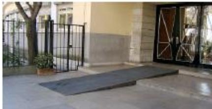
Para respeitar a legislação em vigor, esta rampa foi construída de modo a fazer com o solo um ângulo de  $3^\circ$ , como se pode ver no esquema que se segue (o esquema não está à escala).
